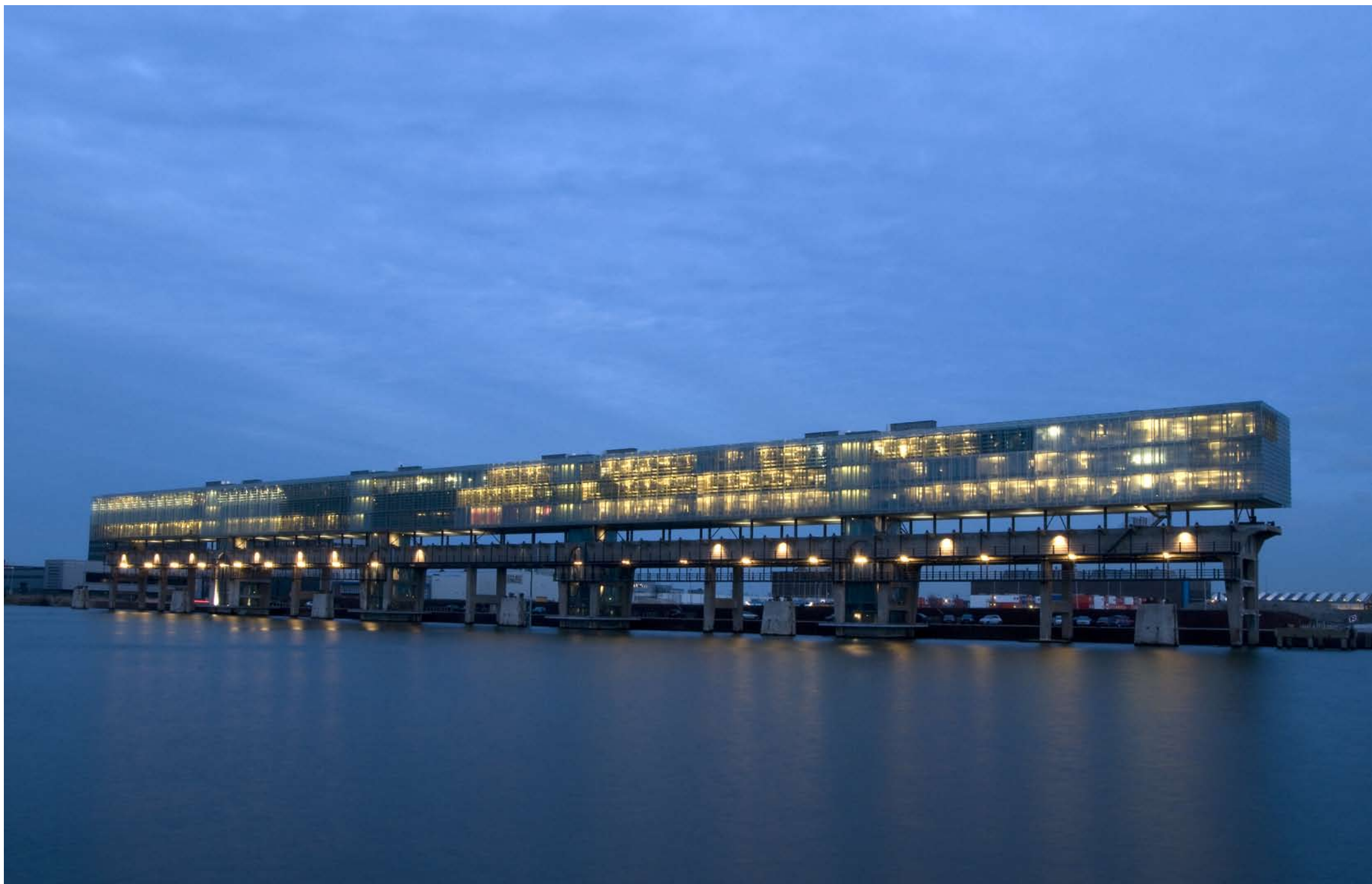
(Het Kraanspoor (foto: Nina Kopp)
